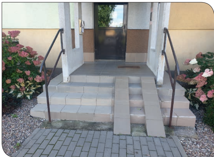
Różane 4 - schody przed remontem
