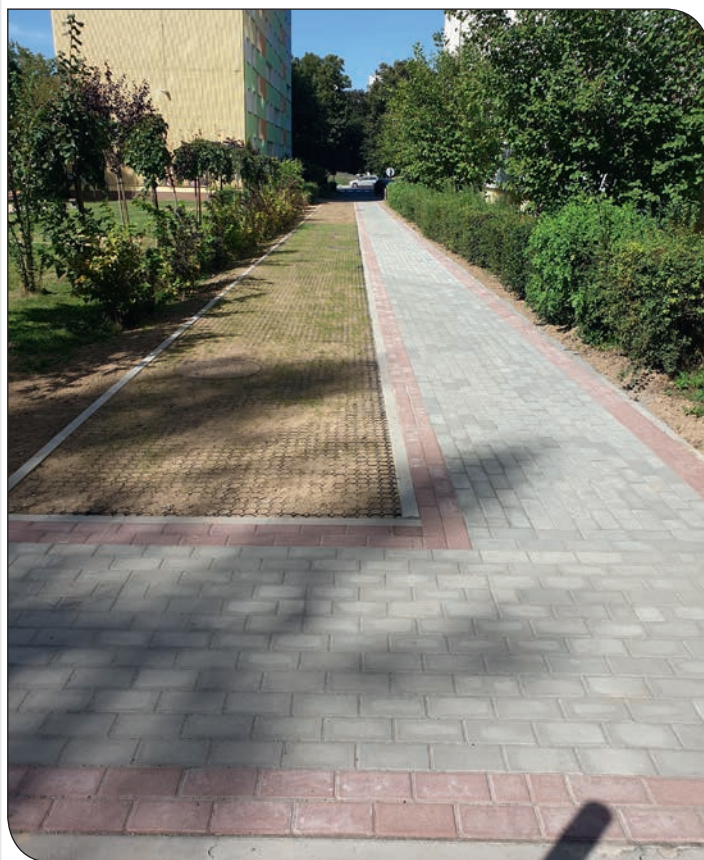
os. Jasne 16 budowa chodnika
