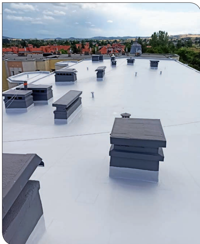
Tęczowe 5 - dach po remoncie
