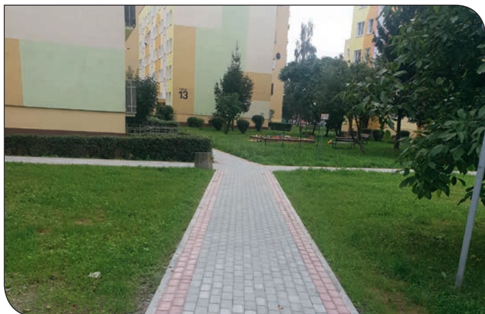
os. Różane 12-15 budowa chodnika
