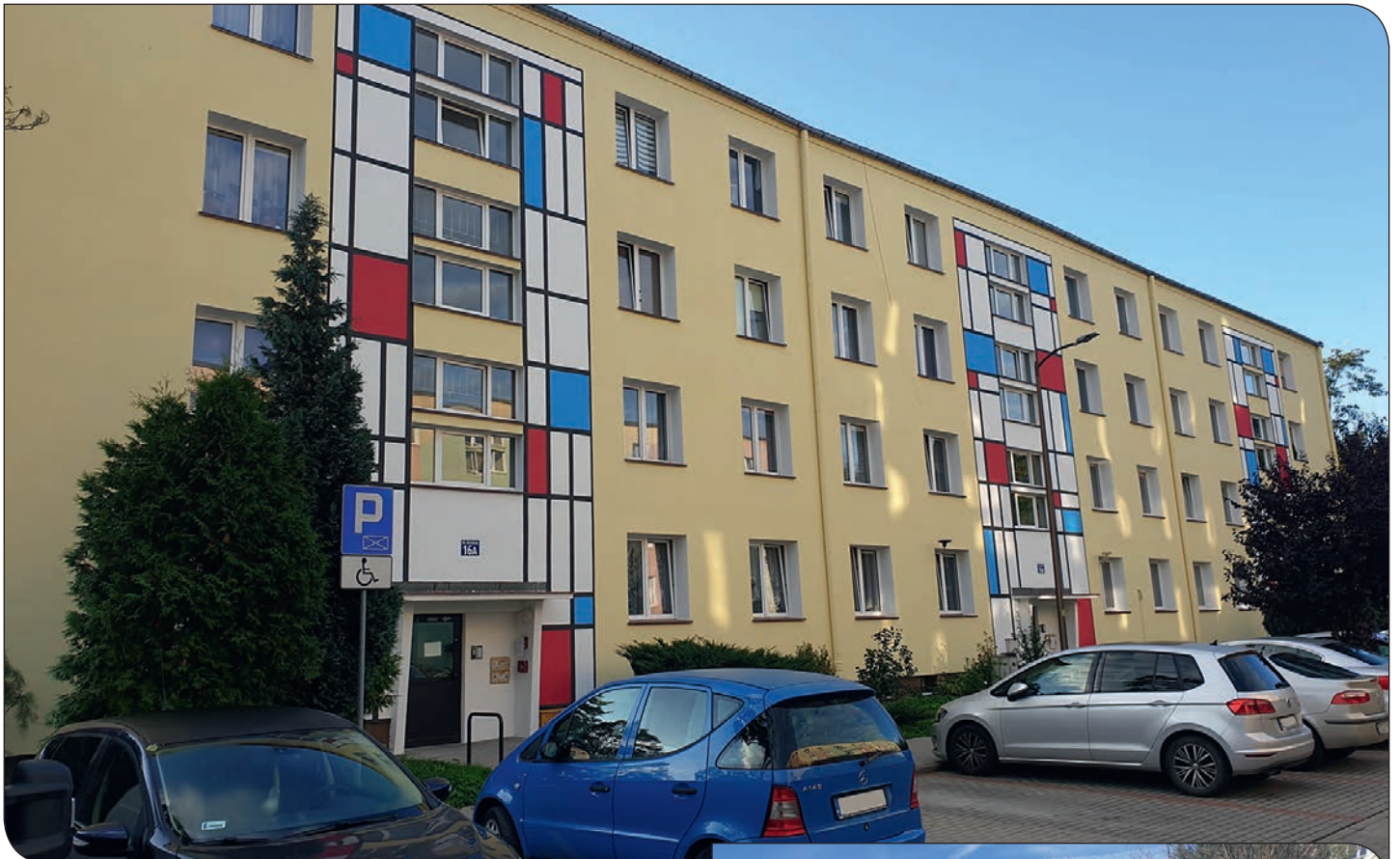
Kolorowe 16 - po malowaniu elewacji
