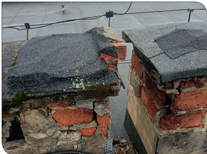
Tęczowe 5 - dach przed remontem
